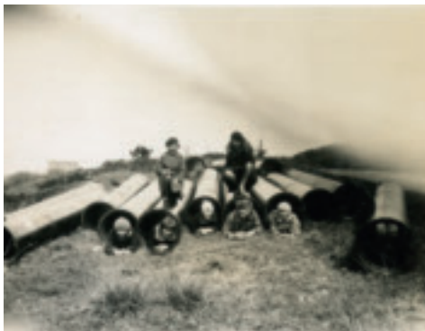
Syv jenter sitter oppå og ligger inni noen store rør.
