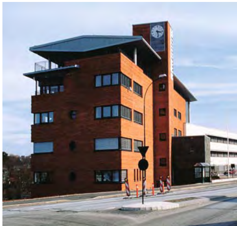
Stavanger politikammer på Lagårdsveien 1996, innledet en ny fase i arkitektkontorets virksomhet.
