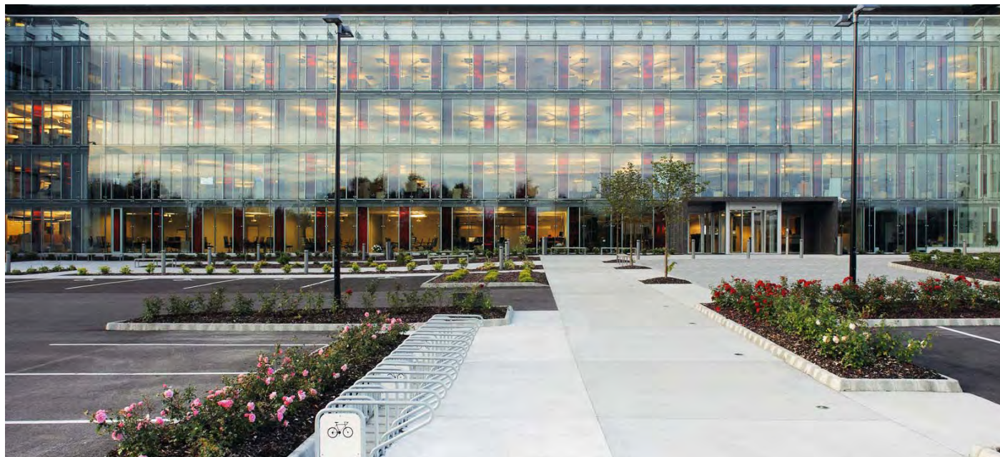
Den storslagne glassfasaden i Vassbotnen 23 bidrar også til å gjøre bygningen energieffektiv Foto: Johannes Marburg
