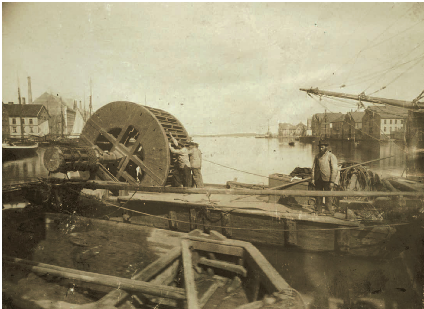
Fig. 31 Stavanger kommune var tidleg ute med fotografisk dokumentasjon av bygningsmiljø og av tekniske arbeid i byen. Dette fotografiet frå 1. mai 1900 viser arbeidet med utviding av kaiområdet i Vågen. Teksten opplyser at dette er ein "Mudderpram i Indre Vågen, sett fra sør. I tredemøllen trengtes seks mann. I bakgrunnen til venstre skimtes den nyoppførte hermetikkfabrikken til John Braadland, Nedre Strandgate 33" (sitat slutt). Foto: Carl Johan Jacobsen. Formannskapetets fotosamling, Stavanger byarkiv.
