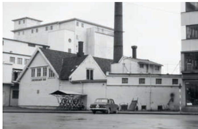
Varmtvannsbadet i Jorenholmsgata 21 ble i 1948 overtatt av kommunen og kalt Jorenholmen Bad. Foto: Gunnar Wareberg. Privatarkiv 156, Statsarkivet i Stavanger
