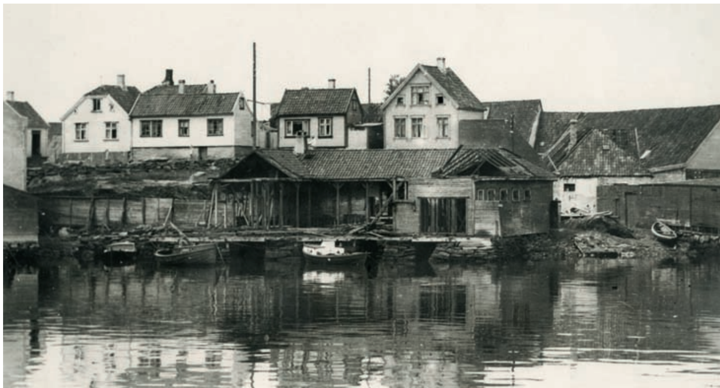
Restene av kaldtvannsbadet i Badehusgata 39, trolig i 1930-årene. Foto: Hans Henriksen. Stavanger byarkiv.
