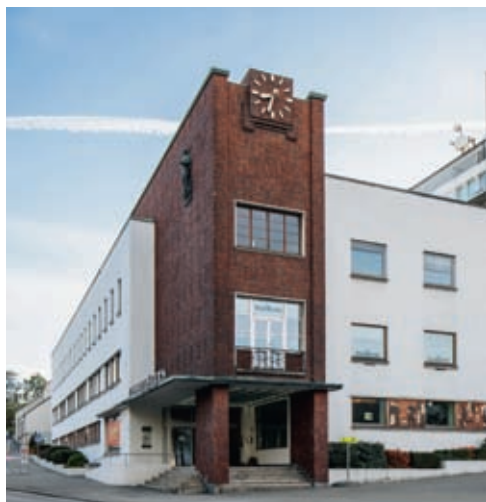
Kannikgården hører til Stavangers vakreste bygninger. Det var Sverre Brandsberg-Dahl som hadde hovedansvaret for prosjekteringen mens han arbeidet for Helland.
