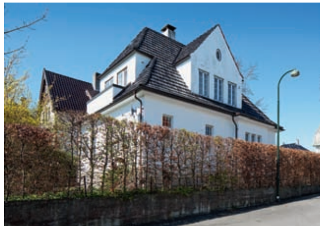
Eiganesveien 72, typisk villa fra «gullperioden i vår villabygging». Foto: Oddbjørn Erland Aarstad
