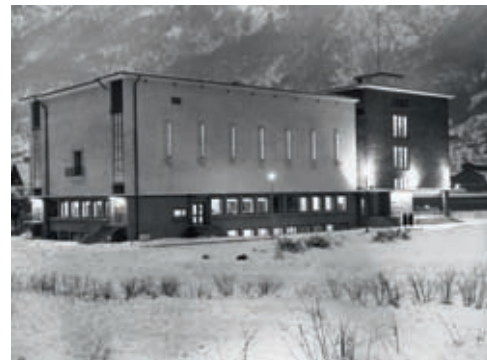
Odda rådhus 1957. Fasaden fra Rådhuseteateret i Sandnes og fasaden fra Kannikgården i Stavanger er koblet sammen til et nytt rådhus i Odda. Foto, Charles Camillo Aggvin, 1957-58, Norsk Vasskraft- og Industristadmuseum.
