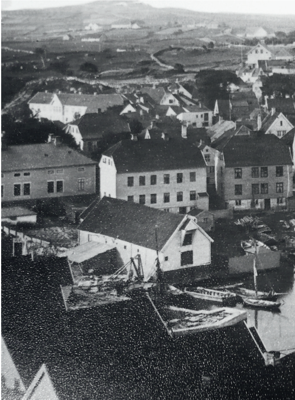
Figur 12: Sjøhuset på Kokkegrunnen er det hvite sjøhuset, omtrent midt på bildet med båter foran. Steinhuset er den lille bygningen, litt lengre oppe til venstre. Like foran sjøhuset skimter en Torvebyggen under bygging. Utsnitt av foto: Carl Lauritz Jacobsen, 26.8.1867. Bildet er i Statsarkivet i Stavanger. 11
