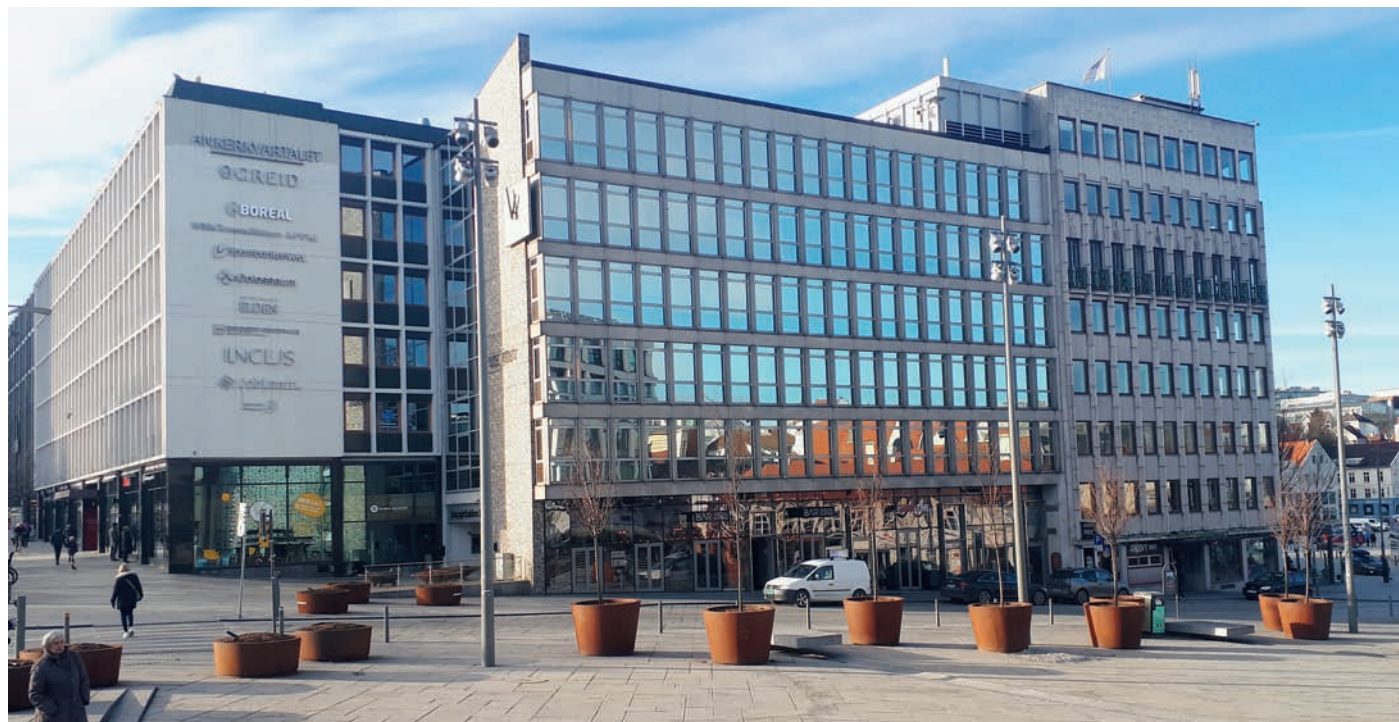
Figur 3: Øverst, fra venstre er Romsøebygget, Kongsgårdbakken 3 og Ankerbygget med Ankertorget nedenfor. Den hvite bilen står i det som var Nedre Strandgate. Grensen mellom Fruehuset og Kokkegrunnen var ved fasaden av Ankerbygget og Kongsgårdbakken 3.
