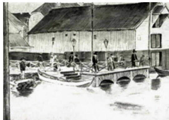
Figur 9: Foran fra venstre er Byfogdbrygga med en mann på. Så kommer Torvebrygga med sjøhuset til Kokkegrunnen bak. Gavlen med skråtak til venstre tilhørte Fruehuset.
