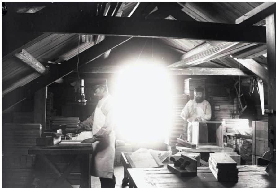
Snekkerloftet ved Stavanger Preserving sin fabrikk i Øvre Strandgate 38. Kreditering: Statsarkivet Stavanger/ Pa-07 Stavanger Preserving.
