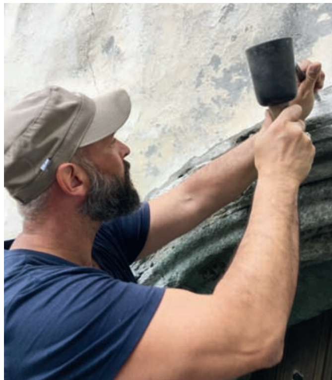
Figur 6. Bygningsantikvar M. E. Erlandsen banker af facadepudsen med knippel og mejsel. Foto Trond Bø 2018
