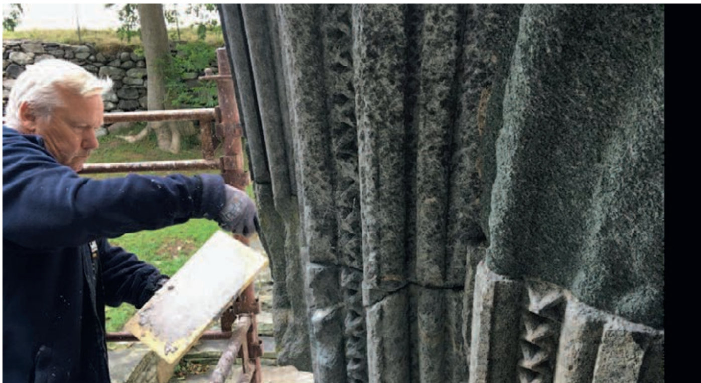
Figur 5. Murermeister Roger Gausland genfuger med kalkmørtel.
