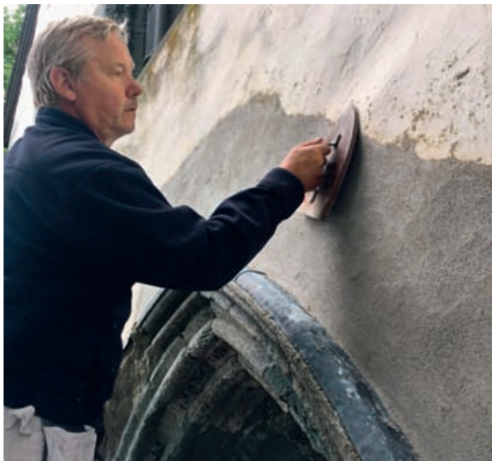
Figur 10. Muremester Roger Gausland filser facaden, så det nye pudslag bliver forbundet med den resterende facadeflade.
