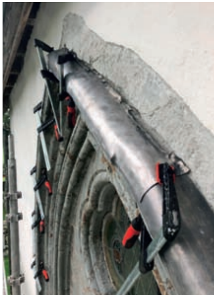
Figur 7. Blyinddækning placeres i mindre stykker over bueslaget.
