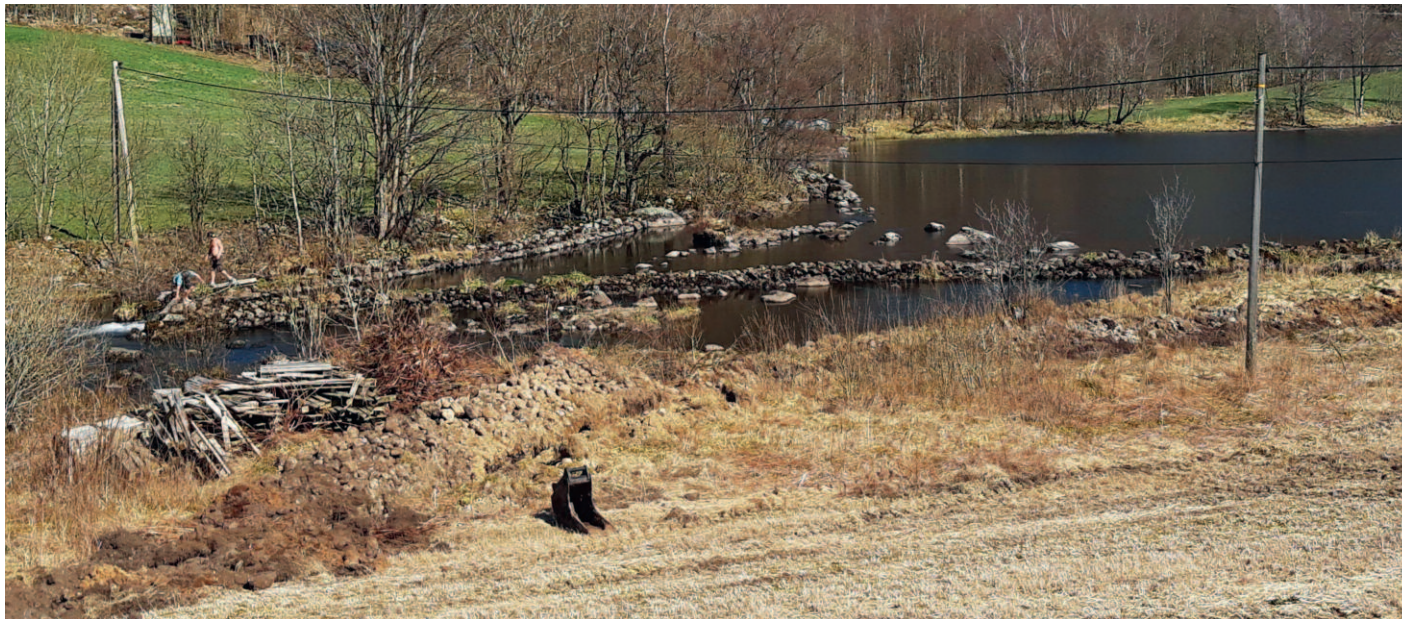
Figur 7: Ålekjerr ved utløpet av Hedlervannet i 2020. Legg merke til de store kraftige ledegjerdene som stemmer opp vannet og leder mot en rist og ålekasse. Anlegget ble laget av farfaren til dagens rettighetshaver. Ved lavt vann kan en se spor etter flere mærgarder som gikk ut av bruk når ålkjerret ble bygget. Oppsamlingskassen og risten er i dag fjernet men finnes fortsatt tilgjengelig dersom fisket i fremtiden skulle bli tillatt. Foto Arild Skjæveland Vivås.
