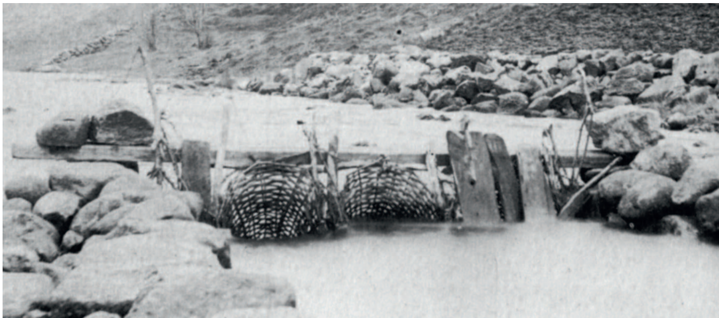
Figur 6: Foto fra 1903 av ålefelle i utløpet av Hedlervatnet. Dette er et mærsog med to mærer fiksert mellom tverrliggerne. Fotoet viser at en brukte de materiale en hadde for hånden til å fiksure mærene og tette åpninger. Hedlervatnet ligger på Kyllingstad som ligger høyt oppe i Figgjovassdraget. Fellen her ble på 1900-tallet erstattet med et ålekjerr som kunne fiske opp mot 1 tonn ål i året (se neste figur). Rettighetene til denne fellen tilhørte ikke grunneieren, men var delt mellom to andre gårder på Kyllingstad som hadde fellen annethvert år. Foto B. Norland, fra Alsvik 1989: 135.
