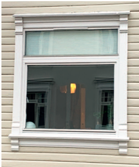
Her er de originale vinduslistene bevart til tross for at vinduene er skiftet til «husmorvinduer». Ved en eventuell tilbakeføring av vinduene vil det være viktig å beholde listene. Foto: Michael Heng.
