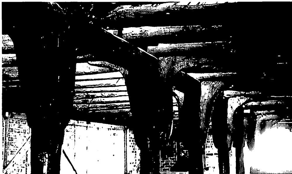
Fig. 58. Avstivning med krumvokste knær. Nedre Holmegate 12-20. Stavanger.
