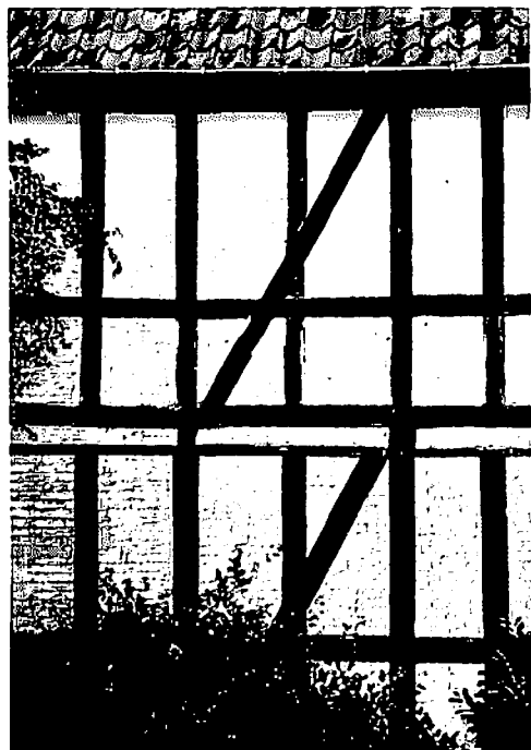
Fig. 42. Bindingsverk. Fåborg, Danmark. Foto: Helge Schjelderup.
