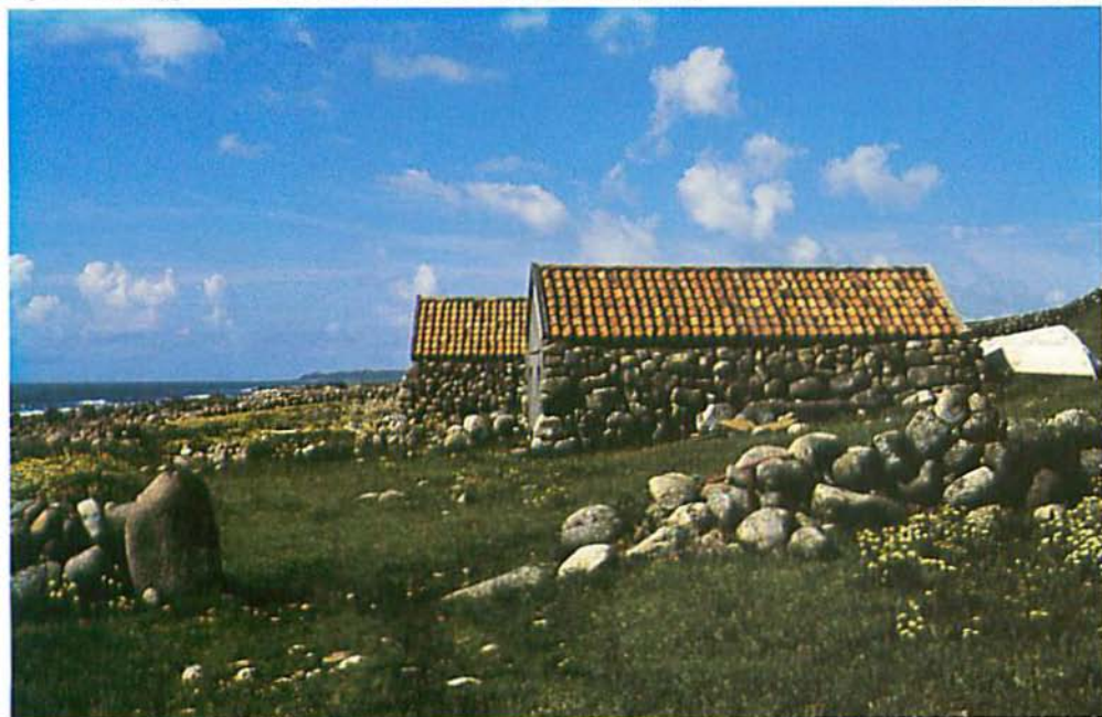
Fig. 13. Grindabygd naust med steinvegger. Nord-Varhaug. Hå kommune.
