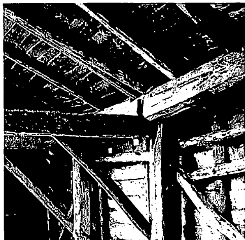
Fig. 63. Bordtak med horisontale suete bord: sutak. Foto: Helge Schjelderup
