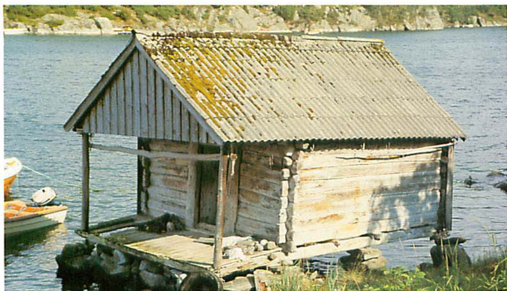
Fig. 24. Sjøbu i laftet tømmer. Sør-Bokn. Finnøy kommune. Foto: Helge Schjelderup.
