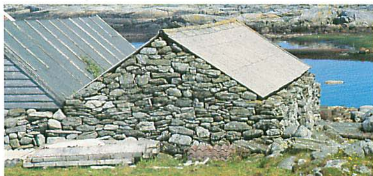
Fig. 19. Steinnaust med hel gavl i stein. Vistvik. Randaberg kommune. Foto: Helge Schjelderup.
