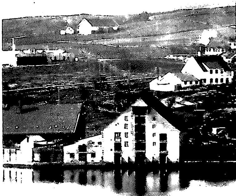
Fig. 82. Køhler-sjøhuset i Hillevåg. Stavanger. 1923.
