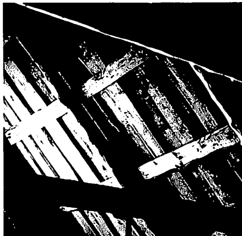
Fig. 64. Bordtak med vertikale over- og underslag. Foto: Helge Schjelderup.
