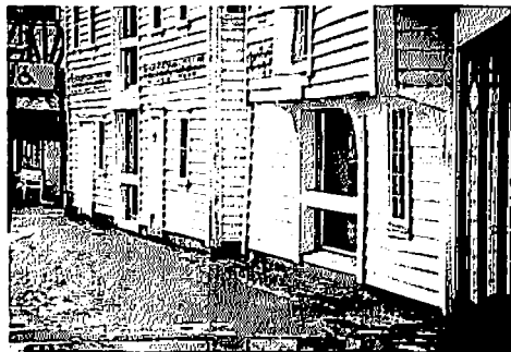
Fig. 62. Krumvokste knær brukt ved utkragning. Nedre Strandgate 19. Stavanger. Foto: Helge Schjelderup.
