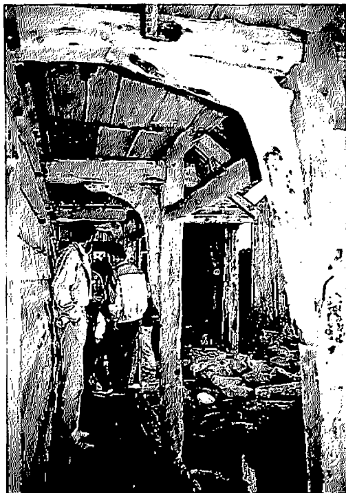
Fig. 62. Krumvokste knær brukt ved utkragning. Nedre Strandgate 19. Stavanger. Foto: Helge Schjelderup.
