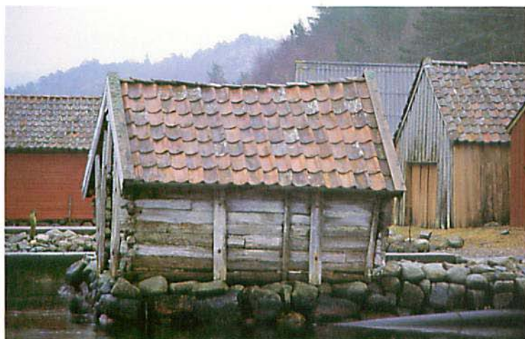
Fig. 23. Sjøbu i laftet tømmer. Lauvåsvågen. Sandnes kommune. Foto: Helge Schjelderup.
