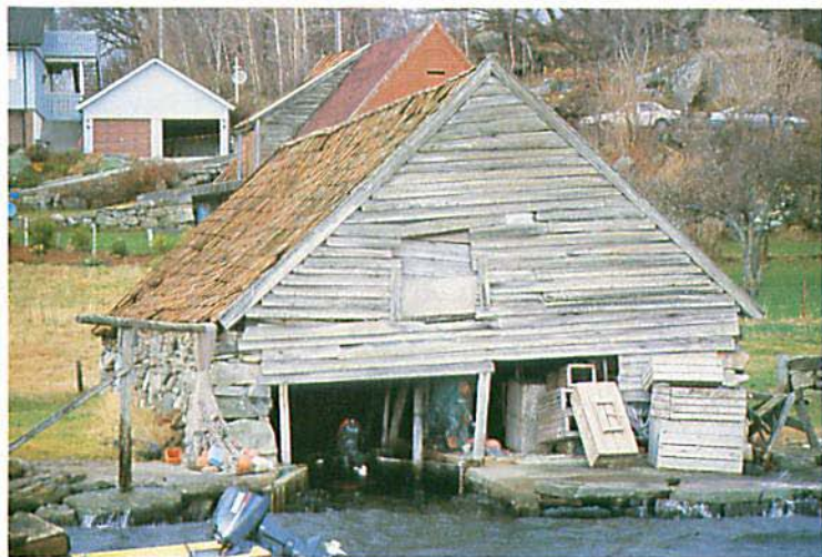
Fig. 35. Steinnaust med loft. (Revet 1991). Lundsvågen. Stavanger kommune. På baksiden ledet en «låvebru» opp til loftet. Foto: Helge Schjelderup.
